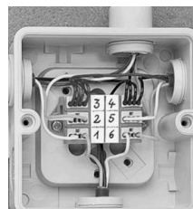
Figure III.11 – Borne micro pour boîte de dérivation 4 conducteurs
